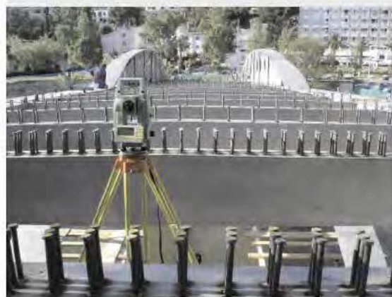
图片 12: 横梁的剪力连接件
