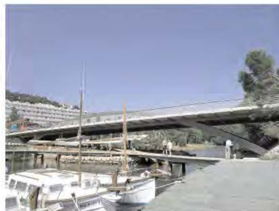
图片 1: 桥梁全貌
